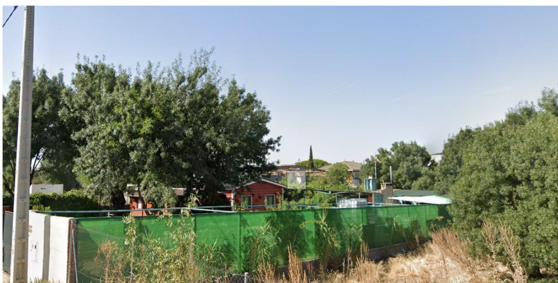
Fig. 37. Vivienda de interfaz con cerramiento de vaya plástica y arbolado como elemento de jardinería.
