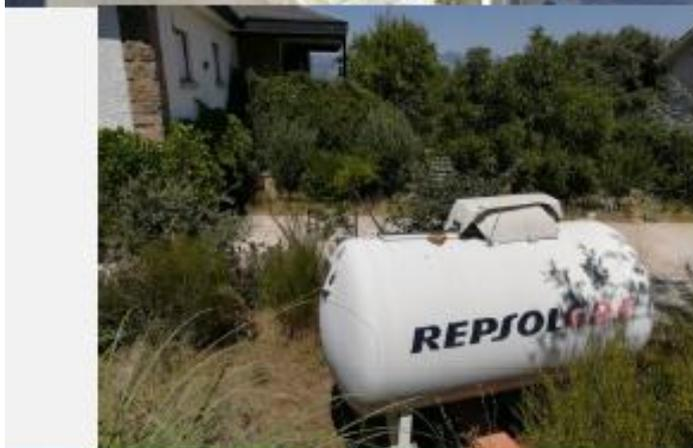
Ejemplo de situaciones de peligro por la presencia de depósitos GLP sin perímetros de seguridad y con elementos combustibles cercanos, ya sean materiales sintéticos o material vegetal vivo y muerto.
