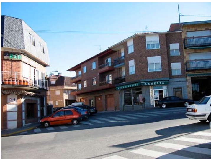
Edificación de los años ochenta
