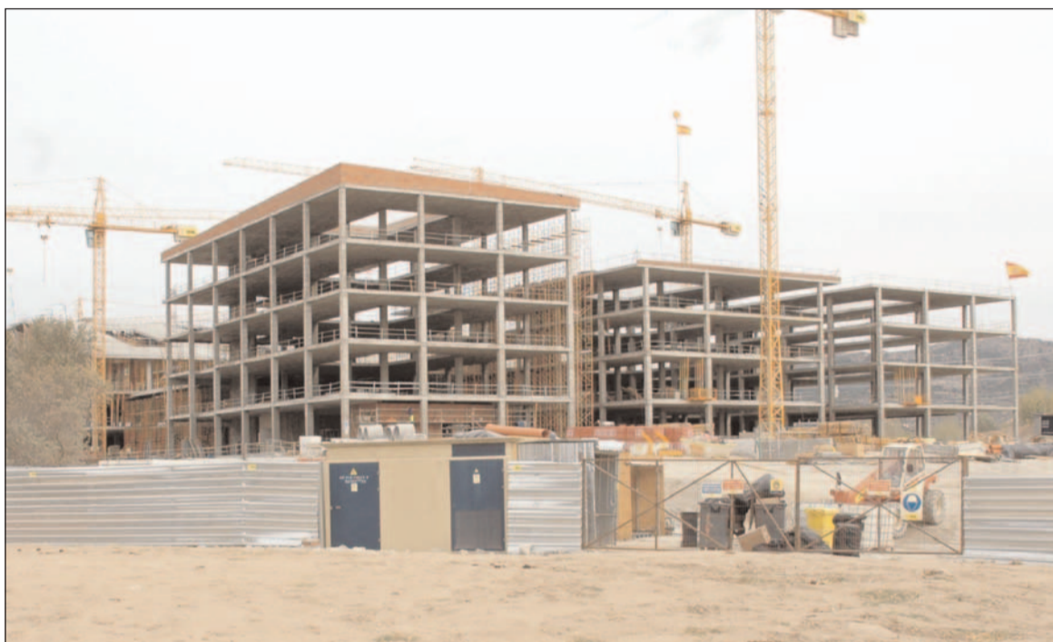
La construcción del hospital va a buen ritmo / AYTO. COLLADO VILLALBA
