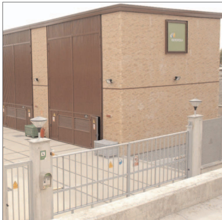
La compactación de la subestación ha finalizado / A.C.V.
